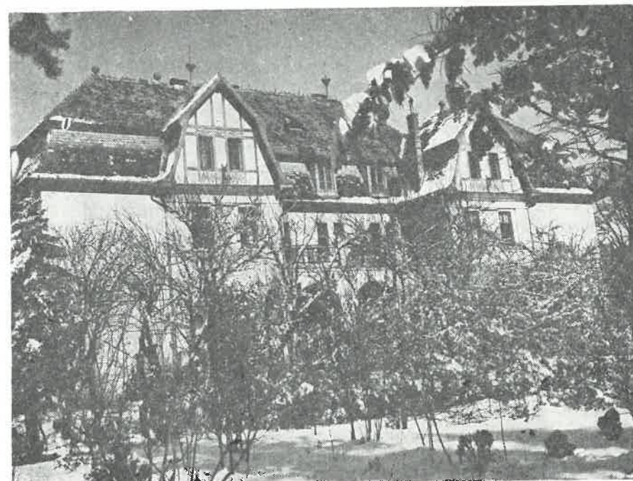
Slika 2. Istočna zgrada Gradske, kasnije Opšte bolnice
